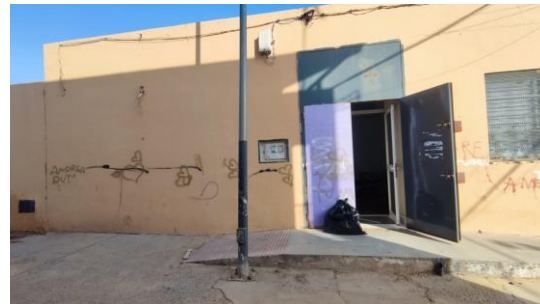
remodelación de la zona.
