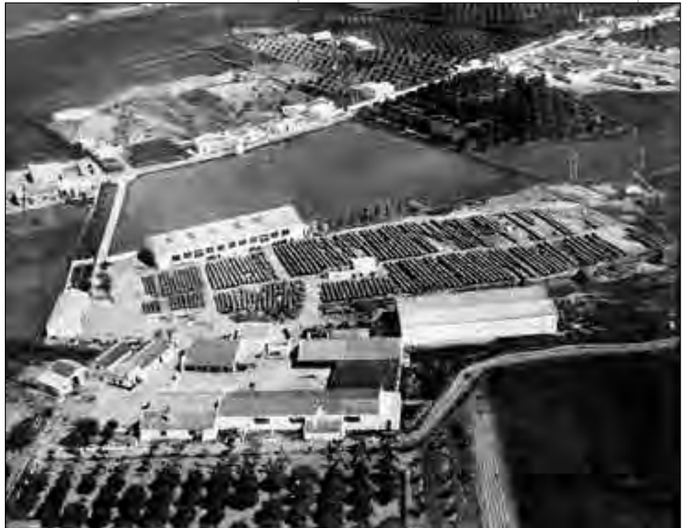
Vista aérea del almacén de aceitunas el Pollo , hacia 1965. Se pueden observar las distintas dependencias y el extenso espacio ocupado por los bocoyes.
