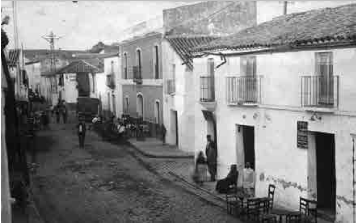
Vista de la calle Larga hacia 1926. En primer término, a la derecha, fonda la Polla (su propietaria aparece sentada en la puerta); a continuación el casino y, al fondo, el pósito municipal, donde se ubicaba la escuela de niños y la cárcel.
