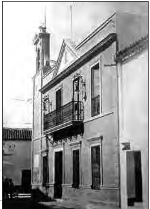
Edificio del Ayuntamiento en 1930, en la esquina de las calles Larga y Murillo (hoy Antonio Pérez Tíno).
