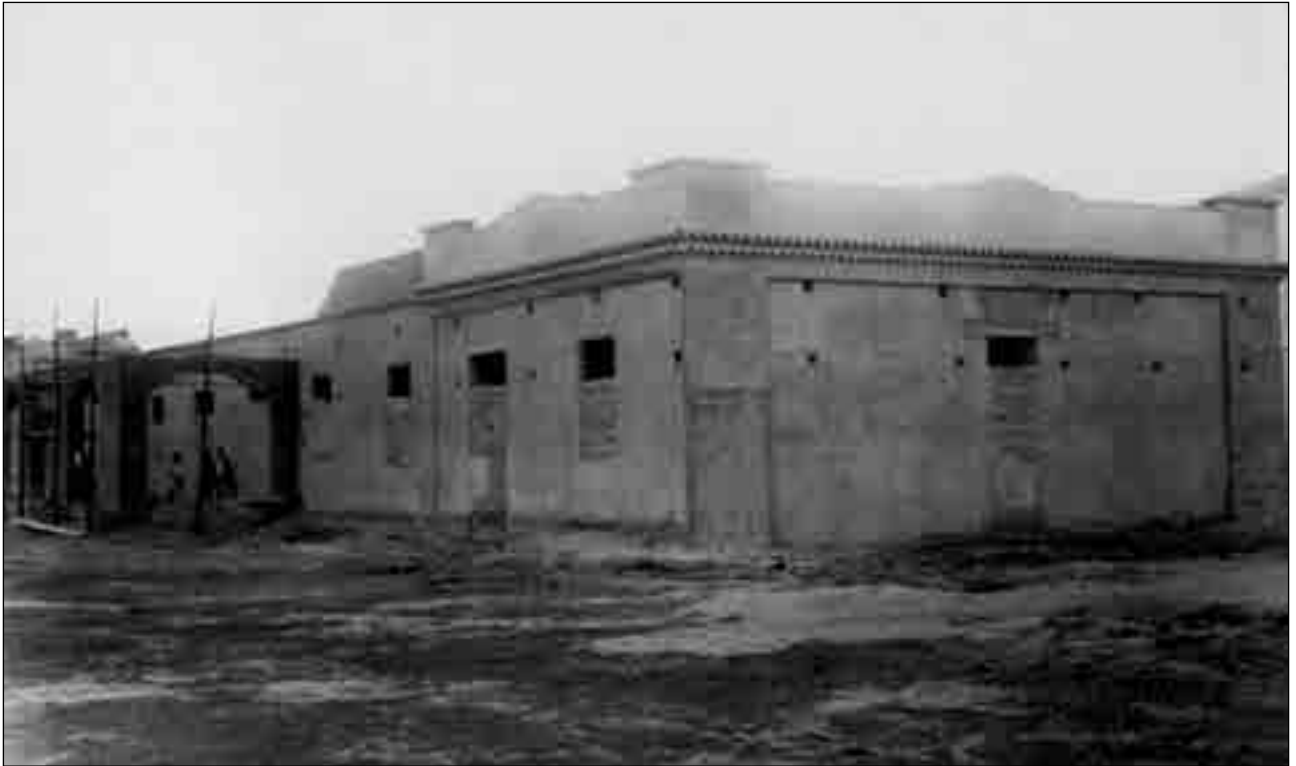
Estado de las obras en el Grupo Escolar Miguel de Cervantes hacia 1945.
