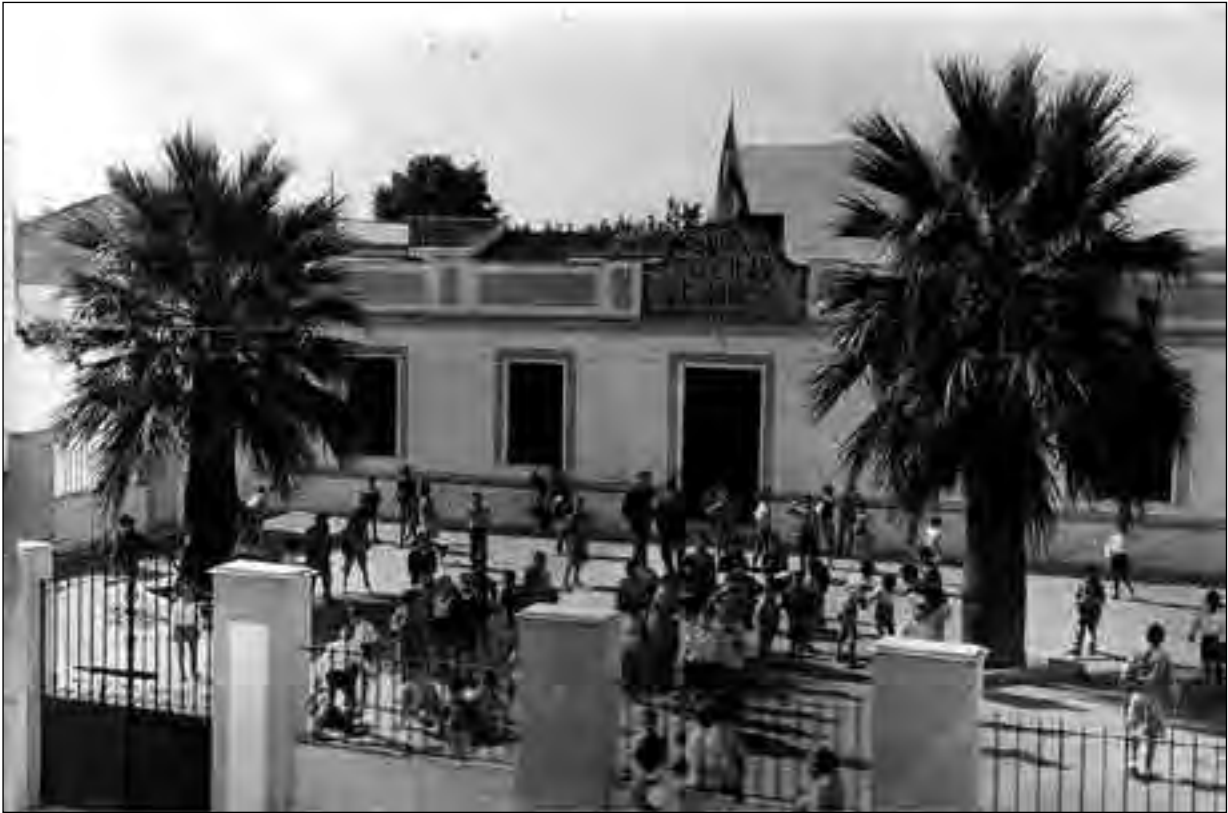
Fachada principal del Colegio Público Hipólito Lobato en 1960.
