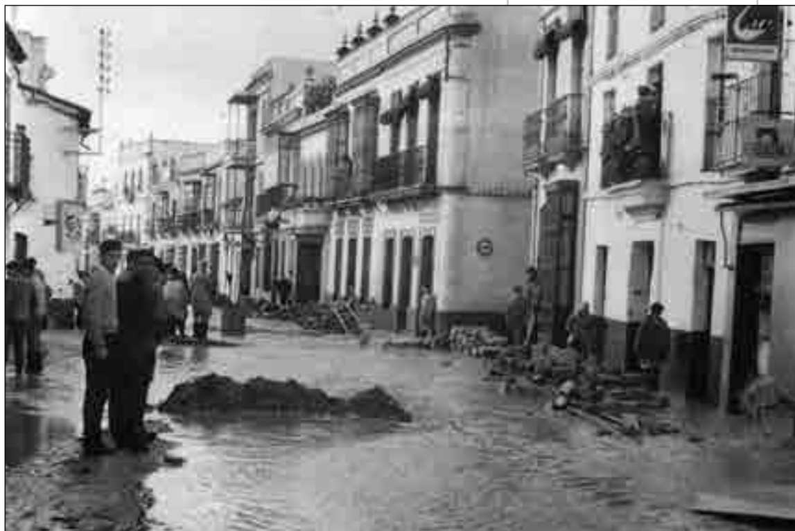
La calle Cervantes anegada por una riada, hacia 1962.
