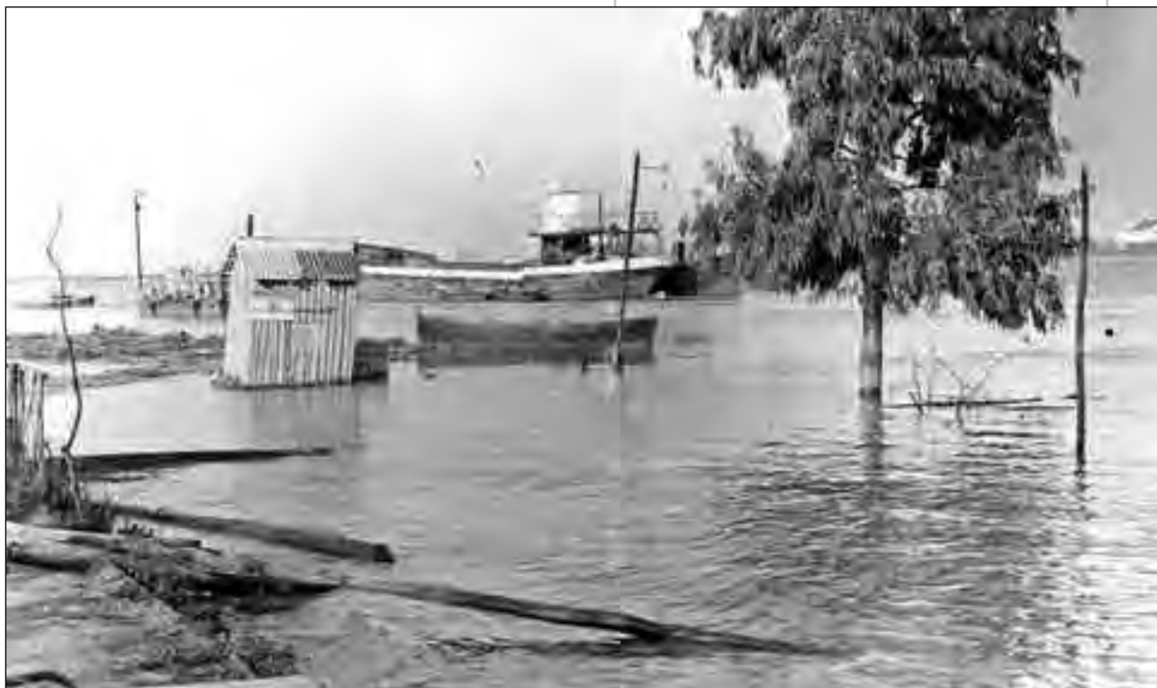
Vista del río durante una crecida, hacia 1966.
