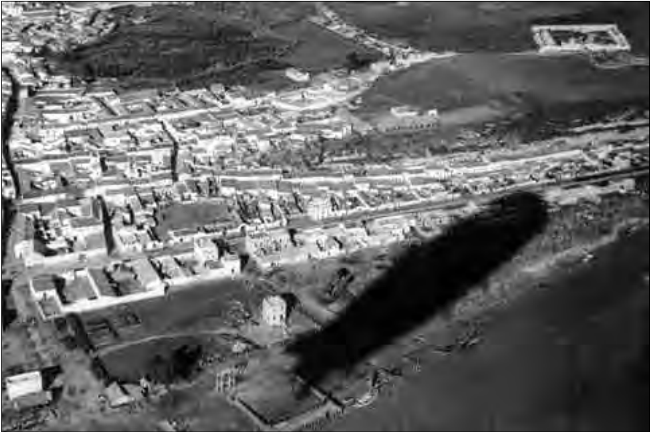
Vista aérea de parte del casco urbano de Coria en 1934 desde el dirigible Graf Zeppelin. En el ángulo inferior derecho se ve el río. En primer término, la actual Avenida de Andalucía y a la izquierda la calle Antonio Pérez Tíno. En el ángulo superior derecho el antiguo cementerio municipal.
