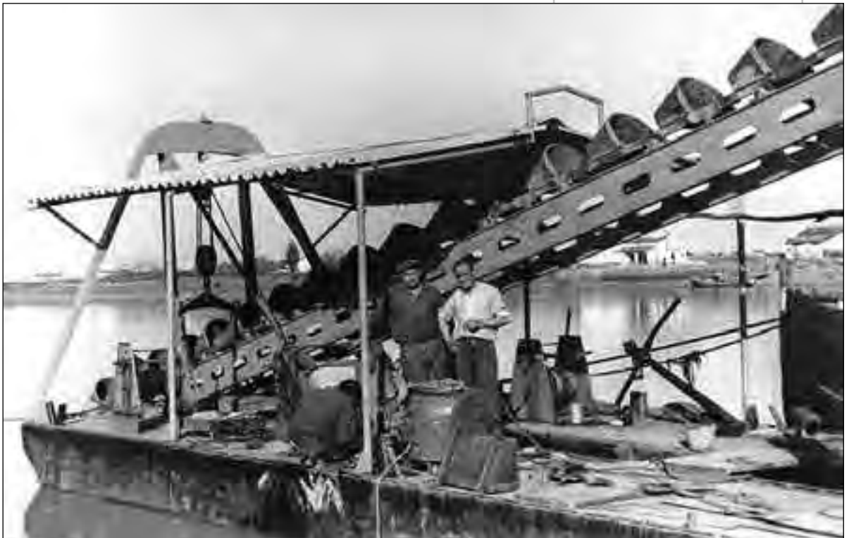
Trabajando en la draga del río en 1963.
