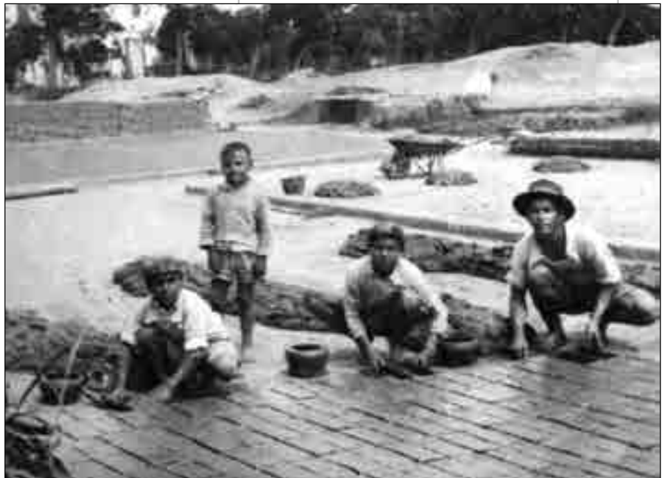
Horno de José Gutiérrez Ruiz Naranjita hacia 1957, situado en la carretera de Coria a Sevilla en la margen derecha del río, junto a Villa Pepita (antigua fábrica de caviar). De izquierda a derecha, los hermanos Manuel, Ramón, Andrés y Antonio Romero Campos.
