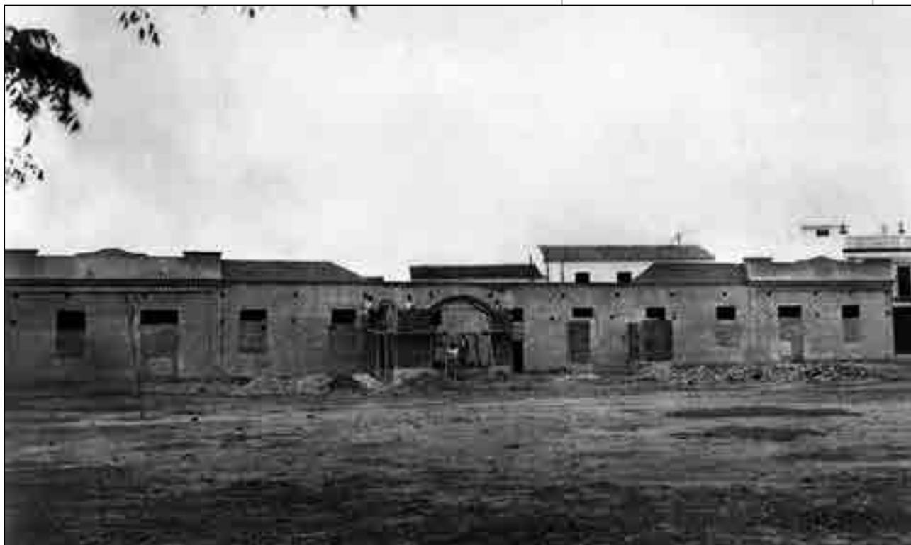
Construcción del Grupo Escolar Miguel de Cervantes, hacia 1945.
