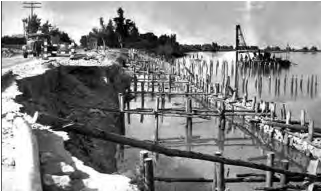
Obras de refuerzo de la margen del río en la carretera a Sevilla, en 1958.
