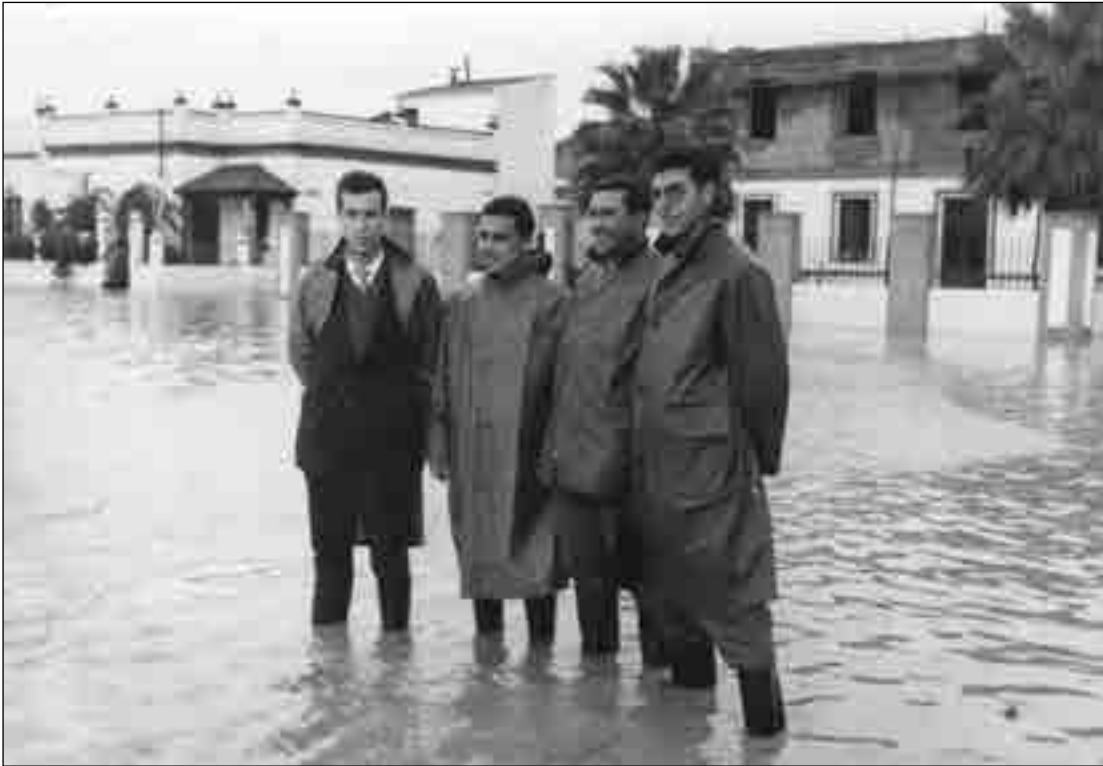
Maestros del Colegio Público El Cerro el 25 de noviembre de 1961 en el Prado de la Soledad, con motivo de una riada. Al fondo, a la derecha, se observa el Colegio Hipólito Lobato en obras para construir el piso superior.
