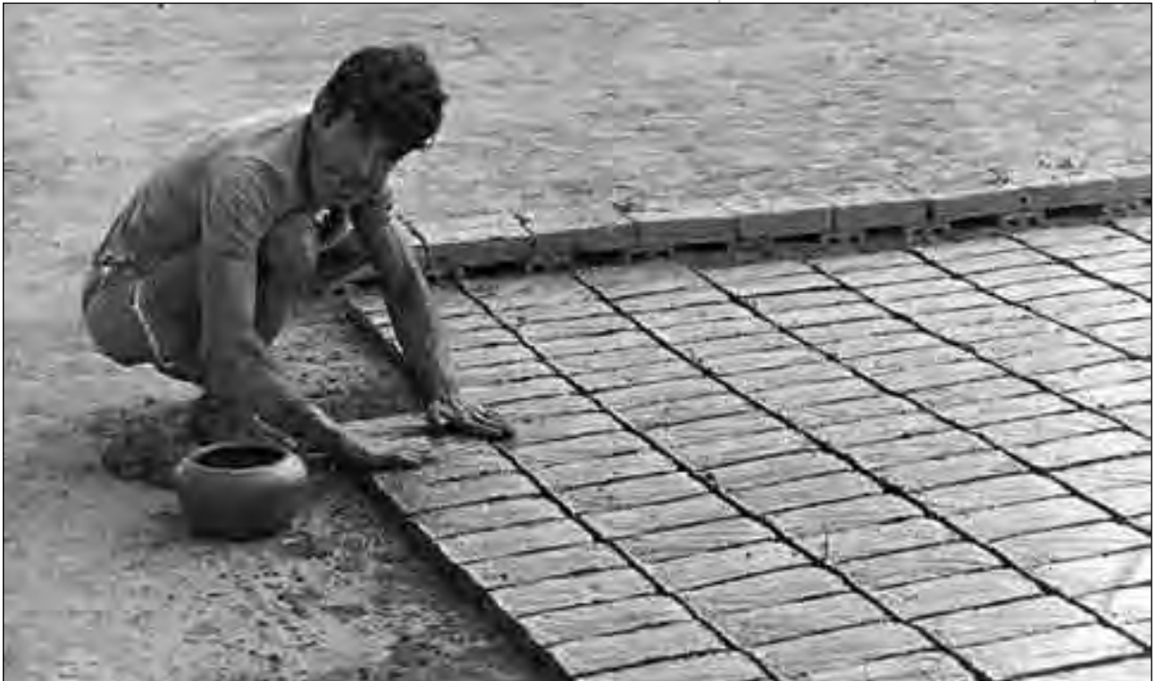
José Raya el Portugués haciendo ladrillos, hacia 1970 A su derecha, el albañal, recipiente para mojar las manos y alisar el ladrillo.
