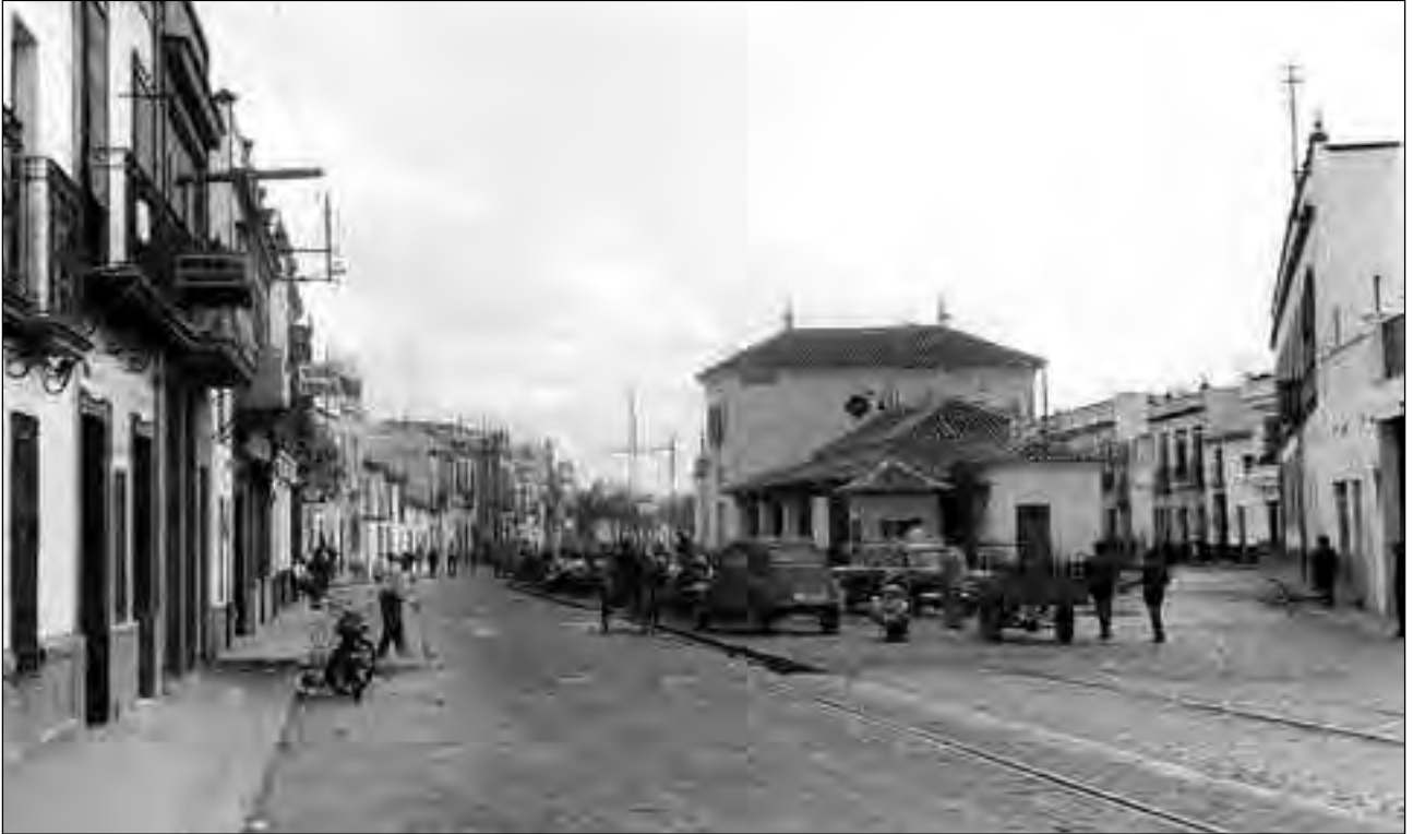
Avenida de Andalucía en 1967, con la estación del tranvía a la derecha, ya fuera de uso.
