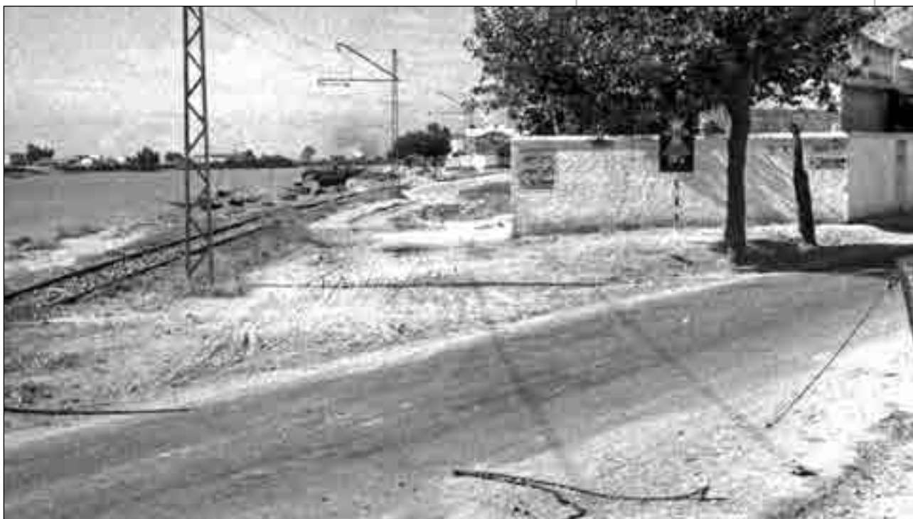
Entrada a Coria desde Sevilla en 1960. En primer plano, la cadena que impedía el paso de vehículos y mercancías cuando se acercaba el tranvía, en la carretera que cruzaba la vía.
