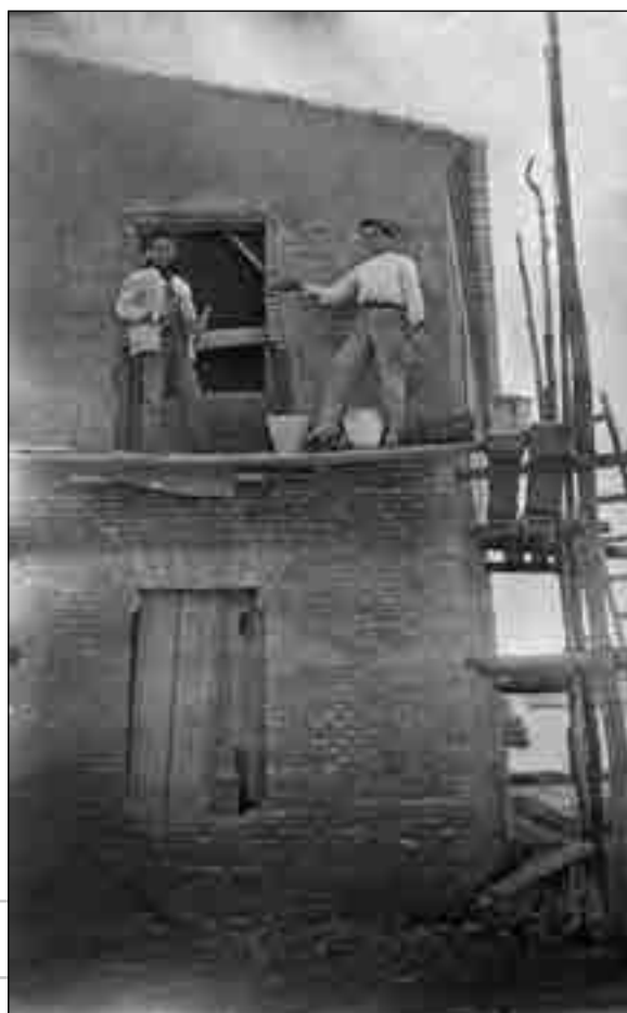
Trabajando en el andamio, hacia 1945.
