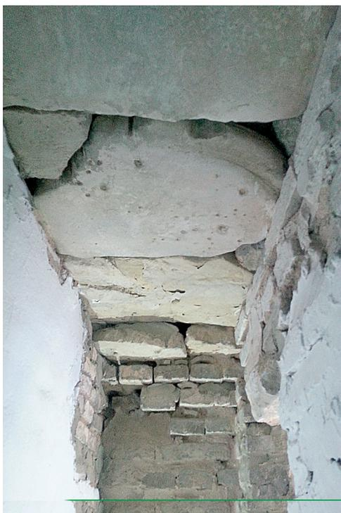
FOTO 7: Cubrición de la escalera interior del muro frontero de la Ermita
