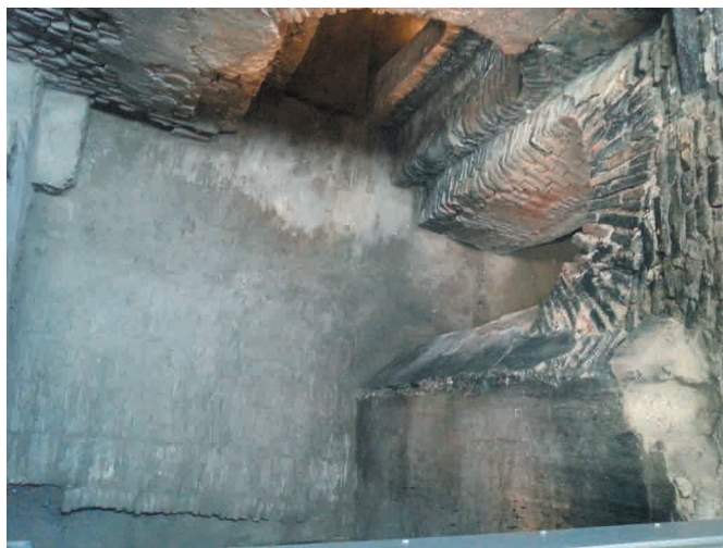
FOTO 5: Vista de una alcatifa que alimentaba de leña a dos hornos del conjunto alfarero de Cerámicas Santa Ana (Triana). En el lenguaje popular de los trabajadores de los últimos hornos de ladrillos corianos, a este espacio lo denominaban “cachifa” y al empleado que introducía la leña en la misma lo llamaban “garabato”.
