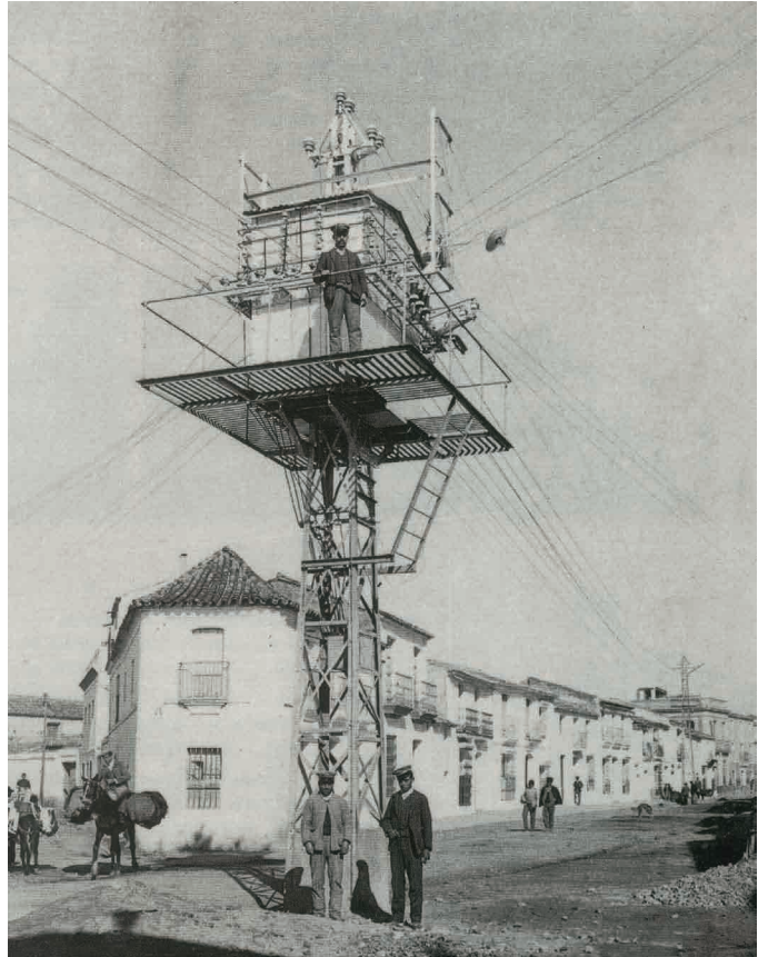
Poste de transformación y distribución de la red en calle Cervantes. 1910. Compañía Sevillana de Electricidad, cien años de historia. Sevilla, 1994.
